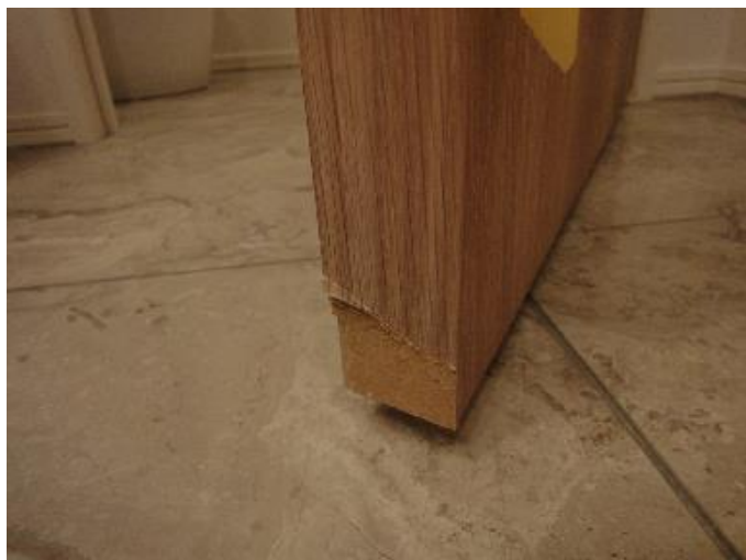
主寝室トイレドアの小口端破損
