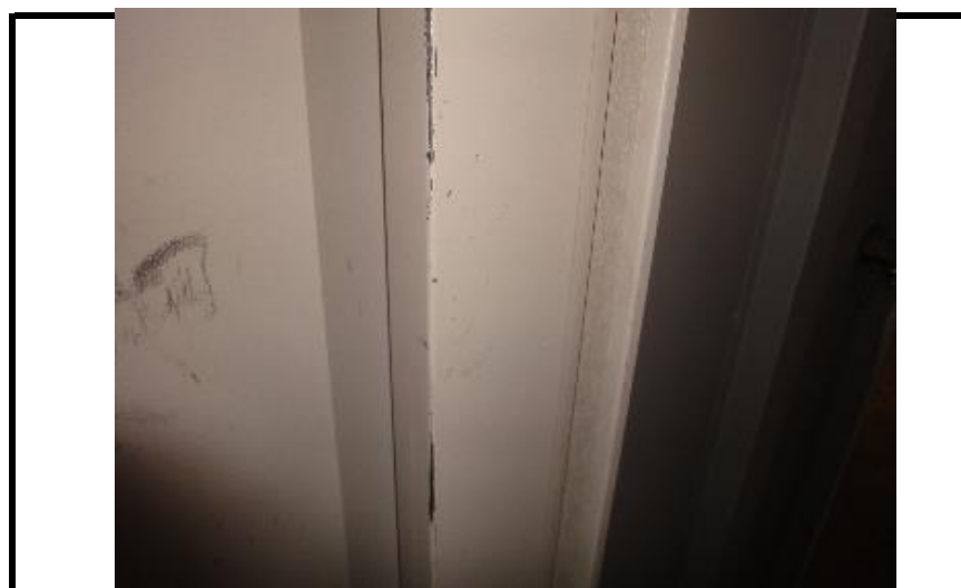
トランクルーム枠塗膜剥がれ
