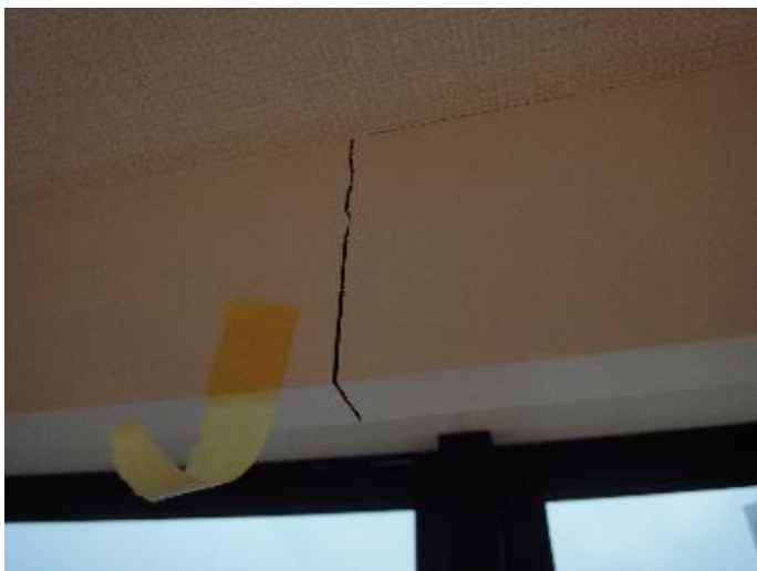
リビング カーテンボックス中央ジョイント隙間
